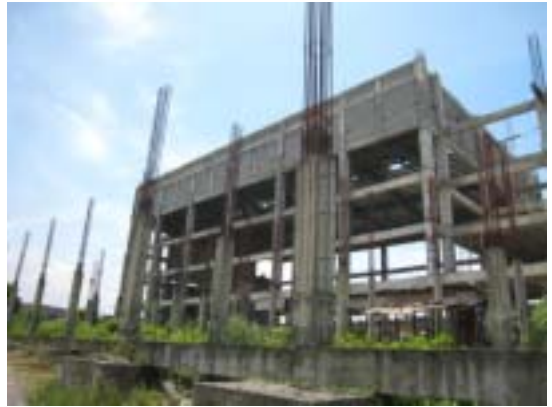
La chiesa in via di costruzione
