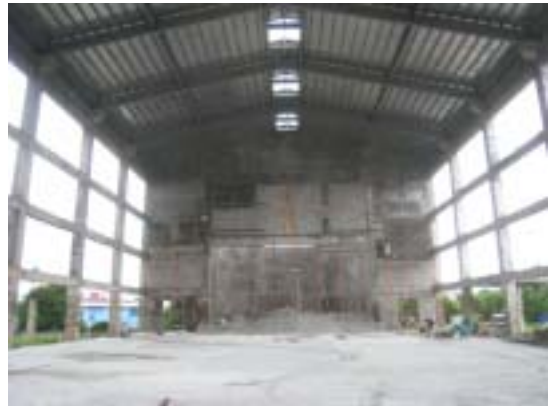
L'interno con il tetto verso l'ultimazione
